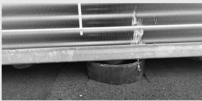
En cas de risque accru de givrage (tenir compte de la situation géographique) il convient de consulter un chauffage de l'écoulement est prévu. La responsabilité de la de l'étude correspondante incombe au planificateur/à l'installateur qui réalise la pompe à chaleur / le climatiseur. Si un chauffage d'évacuation est utilisé si un chauffage d'appoint est utilisé, il faut en informer TECH AG par écrit lors de la commande de la cabine d'insonorisation Silentus ProTECH.
